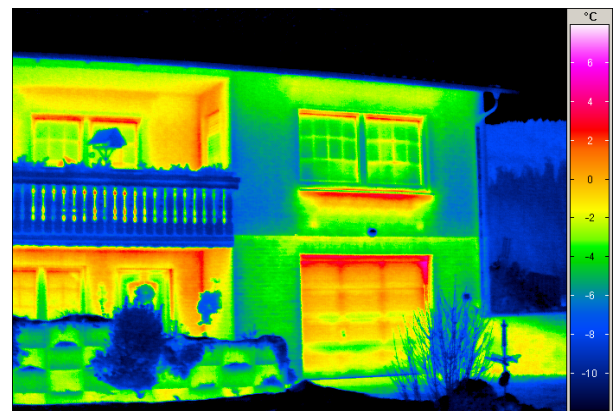
Wärmeverlust unterhalb vom Fenster und am Garagentor erkennbar
